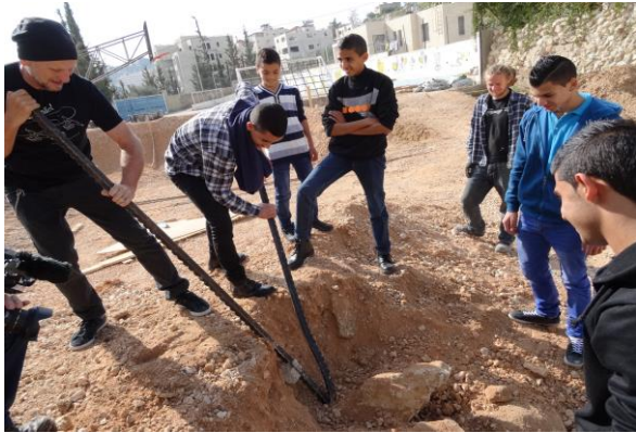
Foto: Titus packt bei den Bauarbeiten mit an © SOS-Kinderdörfer weltweit /Ralph Gladitz
